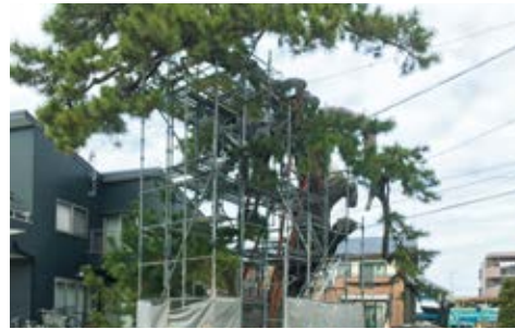
浜松市 樹齢700年 法橋の松 支柱補強
