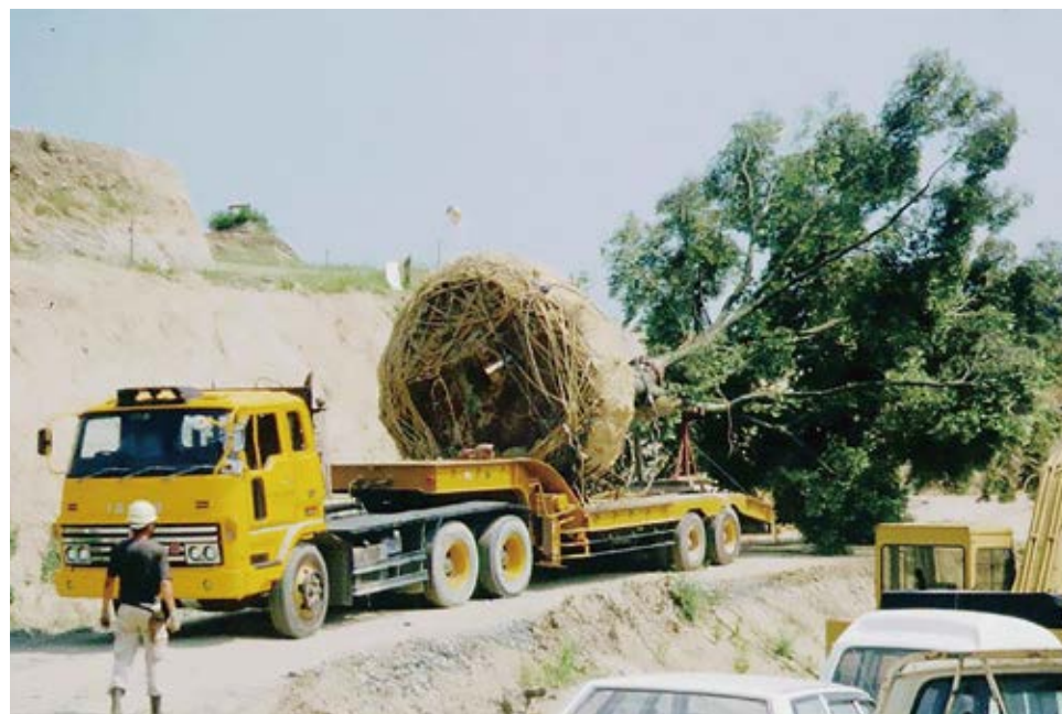
造成地 大径木移植工事
