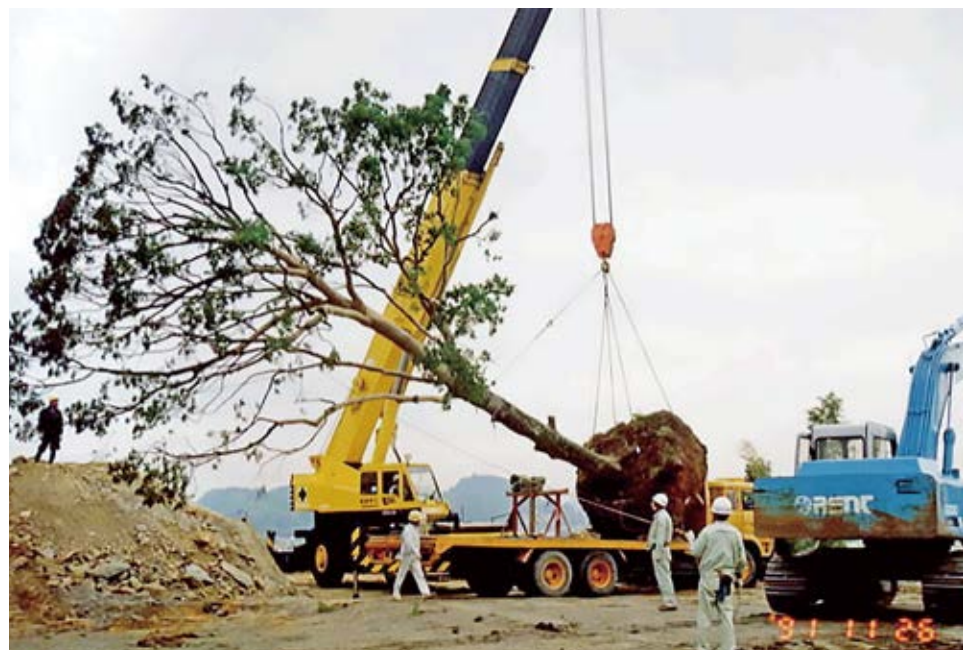
造成地 大径木移植工事
